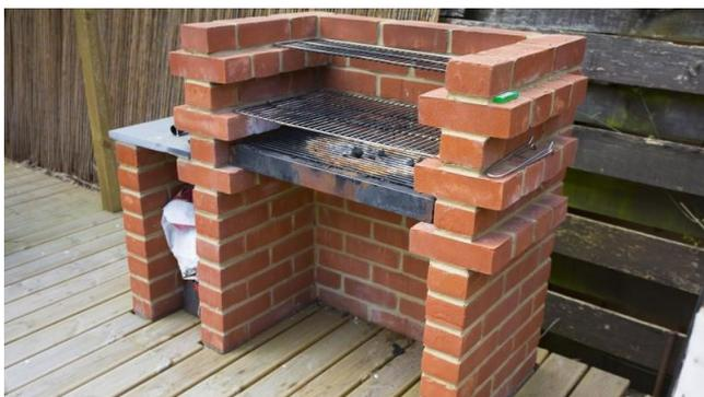
Чтобы защитить углы от сильного ветра, рекомендуется использовать металлический экран с отверстиями. Для защиты рабочей зоны мангала от дождя и снега необходимо изготовить крышку из любого подходящего материала. Чтобы стенки не впитывали влагу, мангал из кирпича на даче следует покрыть лаком, например, КО-85.
