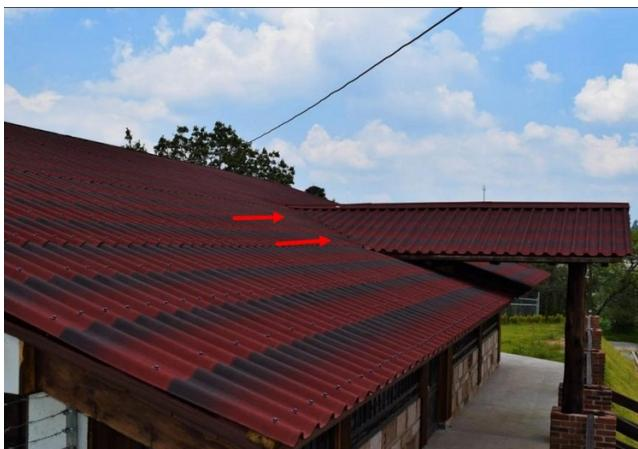
Черепица Ондулин с её красивым внешним видом, сильно напоминает натуральную черепицу. Ендова монтируется «открытым» способом. Она обеспечивает эффективный отвод воды, предотвращает скопление мусора и образование ледяных пробок зимой.
