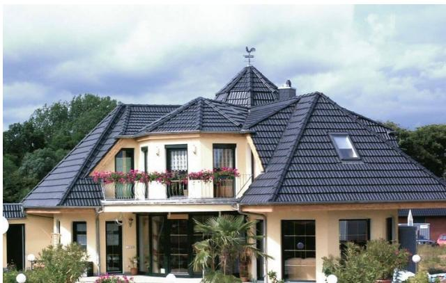
Такие дома популярны на севере Германии — в Гамбурге и Бремене. Их крыши имеют много изломов, что делает их особенно привлекательными. Для достижения идеального внешнего вида и предотвращения протечек в местах внутренних углов во время осадков, особое внимание уделяется качеству монтажа ендовой.
