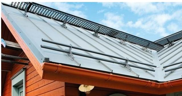
Слева и справа от ендовой на фальцевой кровле установлены снегозадержатели. Они способствуют равномерному распределению нагрузки от снега на всю кровельную конструкцию, в том числе снижается нагрузка на ендову, а значит она прослужит дольше.
