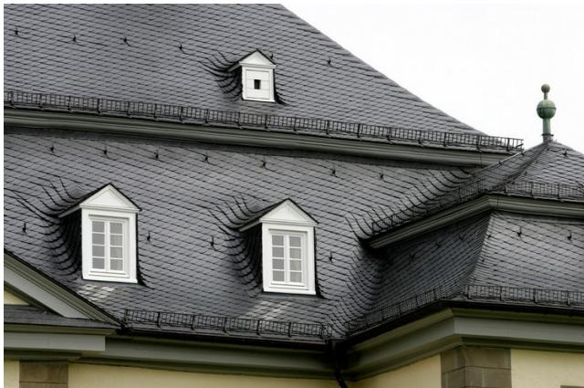
На фото сланцевая крыша. Посмотрите, как идеально выполнены все изгибы. Крыша словно покрыта чешуйками дракона. Данная работа по монтажу ендovy достойна самой высокой оценки.
