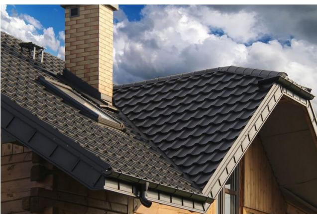
Обычно на крыше, покрытой металлической черепицей, предпочитают монтировать закрытую ендову, чтобы красиво оформить обрезанные края металла. Однако, на представленном фото мы видим пример с открытой ендовой, где используется только нижняя планка.
