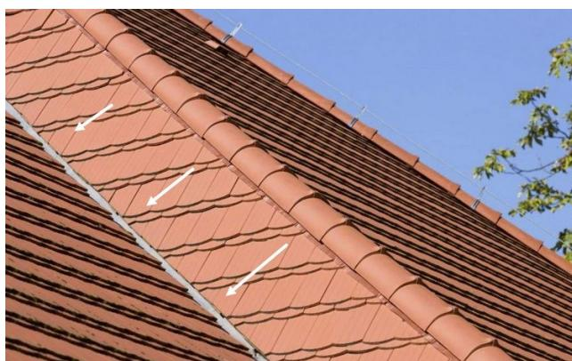
На фотографии выше в качестве материала для монтажа открытой ендовой использовался алюминий. Данная ендоша не боится коррозии и обеспечивает надёжную защиту от протечек (при правильном монтаже).
