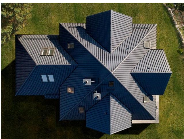
Сложная многощипцовая крыша с мансардой внутри. Все линии и углы наклона чётко спланированы проектировщиками.
