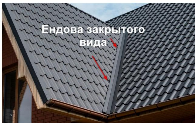
Стоит отметить, что закрытую ендошу в основном монтируют на кровлях из металла, чтобы закрыть неровный рез. На других кровлях, например, при использовании таких материалов, как Ондулин Смарт, Черепица Ондулин, Ондувилла, гибкая или керамическая черепица — ендошу делают открытой.
