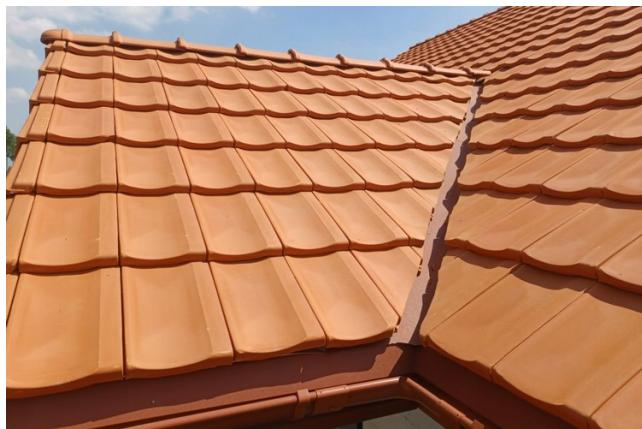
Ендоша на крыше из керамической черепицы. Используется только одна нижняя планка из оцинкованной стали, окрашенной в цвет кровельного покрытия.
