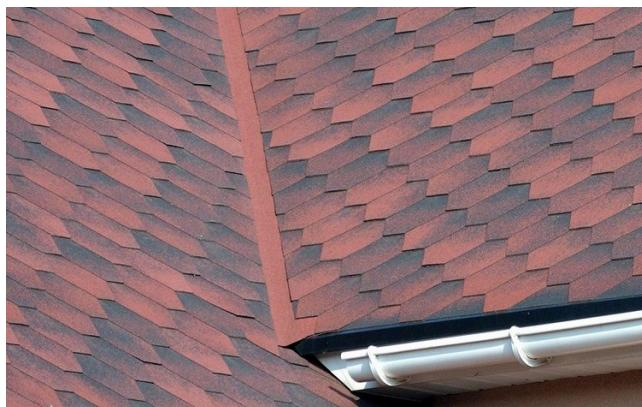
Ендова на крыше из гибкой черепицы. Для монтажа используется специальный подкладочный ковёр.
