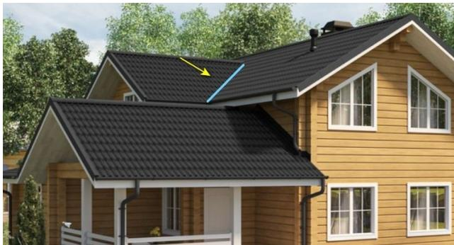
Ендова — часть кровли, внутренний угол, образованный двумя скатами. Это место также известно, как «разжелобок». Его основная функция — обеспечить отвод талой или дождевой воды с крыши дома.
