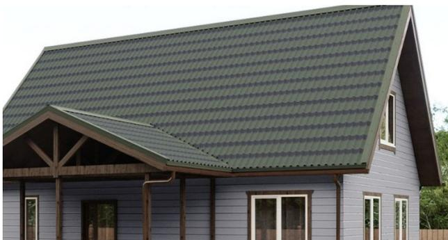
Ендова защищает от атмосферных осадков внутренние углы крыши между двумя скатами. Если она смонтирована правильно, то система будет герметичной, талая или дождевая вода не смогут попасть в подкровельное пространство, а значит, крыша прослужит дольше, и в помещениях верхних этажей не будет капать с потолка.
